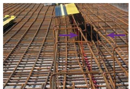
**FIRIPA Anschlusskorb:** Die Befestigung der RASCOtec Sollrisselemente an die Hilfs-, Stützkonstruktion erfolgt in der Regel mittels Kunststoff-Kabelbindern.
